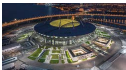
Зенит Арена. Освещение периметра (г. Санкт-Петербург)
