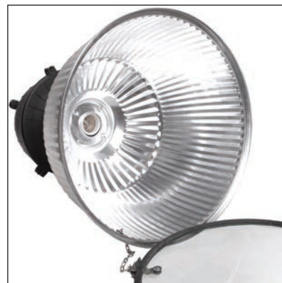
Шаг 2. Демонтаж лампы светильника
