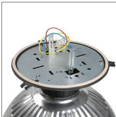
Шаг 1. Демонтаж балласта светильника
