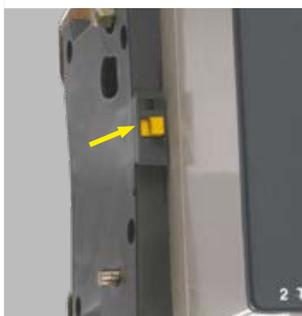
Индикатор положения контактной системы вынесен на внешнюю панель боковой крышки. Это позволяет проверить положение рабочей группы контактной системы, не разбирая контактор.
