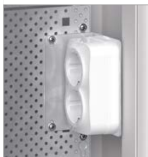
Розетка для подключения активного оборудования.
