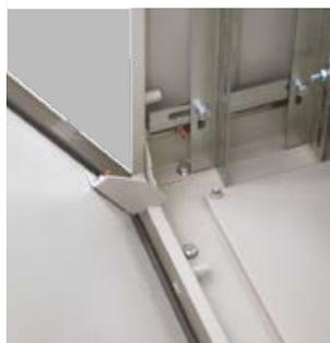
Ножки на задней стенке в габаритах 1600 (1800)×600×400 и 1600 (1800)×800×400 мм упрощают ее установку и повышают безопасность обслуживания шкафа.
