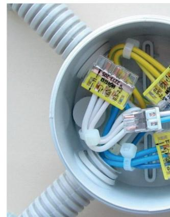
Клеммы CMK и для соединения и изоляции
