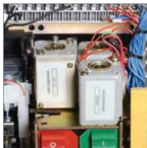
Независимый расцепитель, минимальный расцепитель и катушка включения
